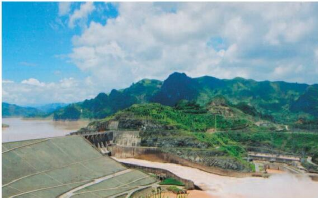
Hình 2. Đập ngăn nước của Nhà máy Thủy điện Hoà Bình
